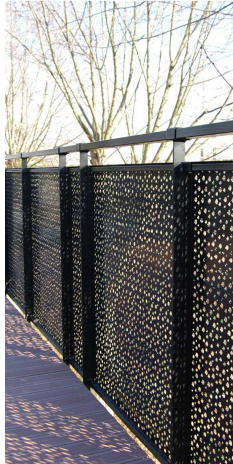
Garde corps en tôle perforée
