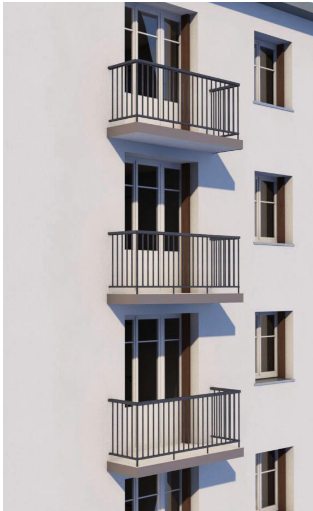
Garde corps à barreaudage + habillage nez de dalle
