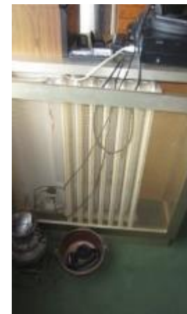
Mauvaise pratique : couvrir le radiateur et gêner la diffusion de la chaleur
