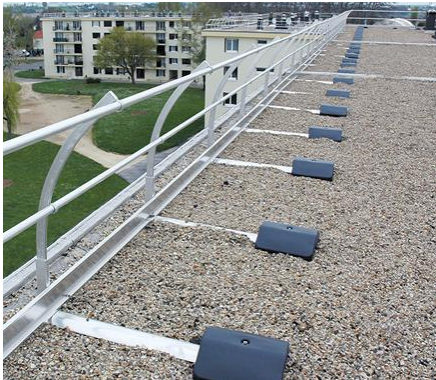
Mise en sécurité des toitures terrasses ≈ 120 000 €
