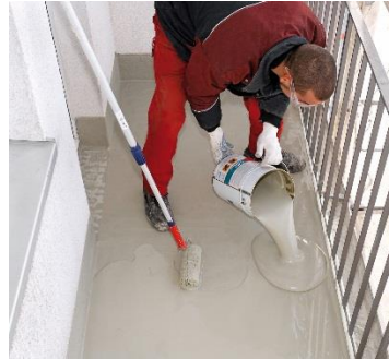
Étanchéité des coursives et balcons ≈ 130 000 €
