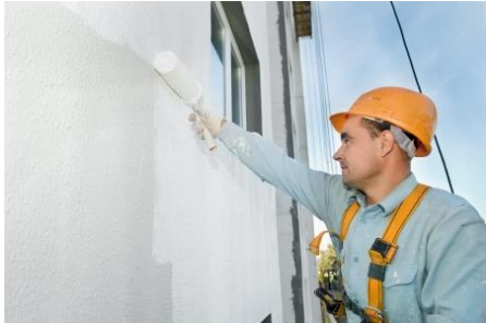
Ravalement et isolation des façades ≈ 1 165 000 €
